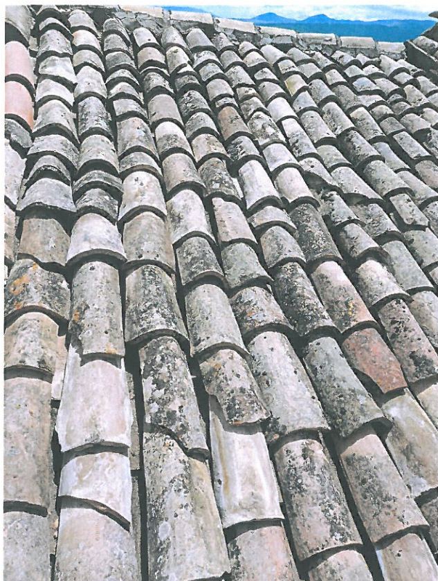
Vista finale del tetto
