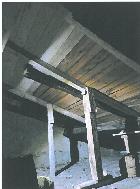
Particolare della puntellatura di alcune travi esistenti
