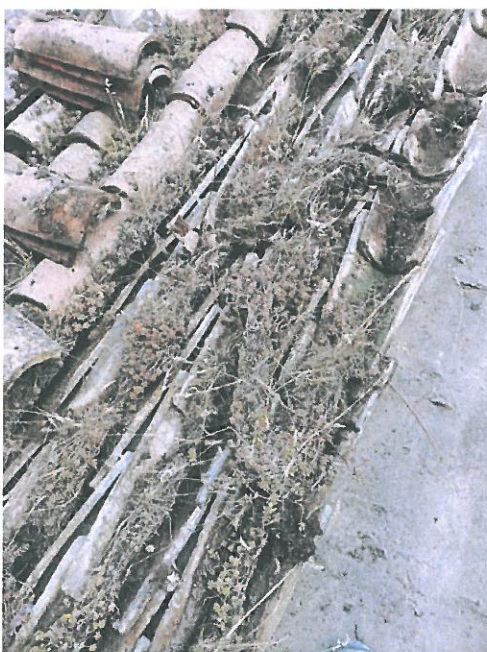
Stato del manto di copertura
