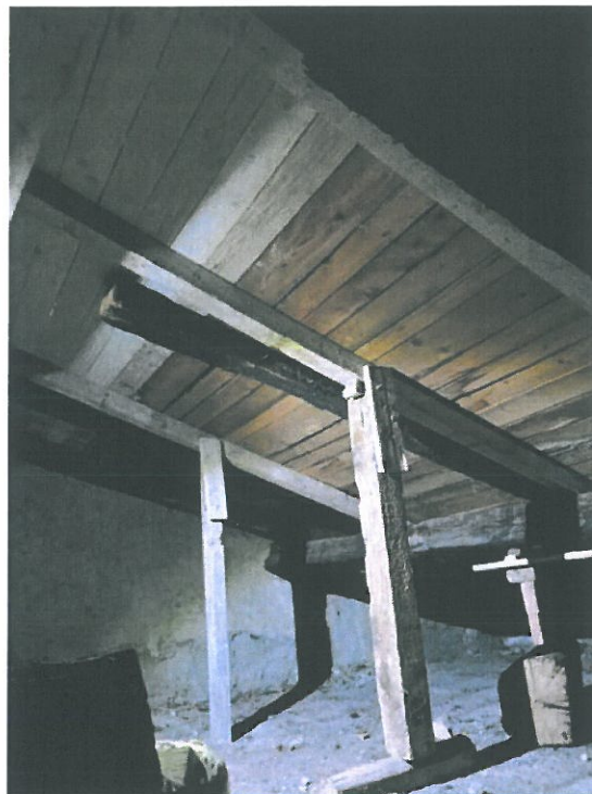
Particolare della puntellatura di alcune travi esistenti
