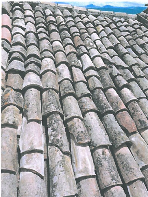
Vista finale del tetto
