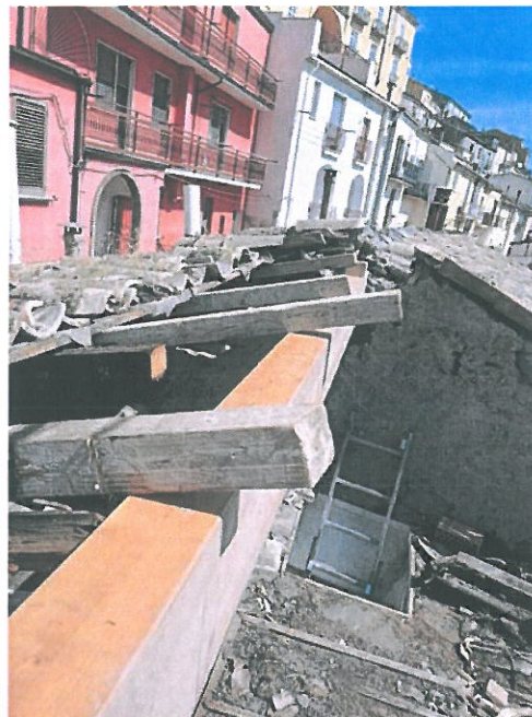
Trave di colmo ed altre travi sostituite
