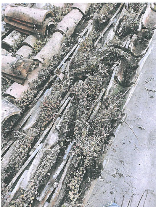
Stato del manto di copertura
