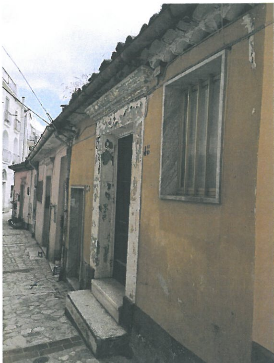
Foto 1 – Vista dell'ingresso al piano terra
