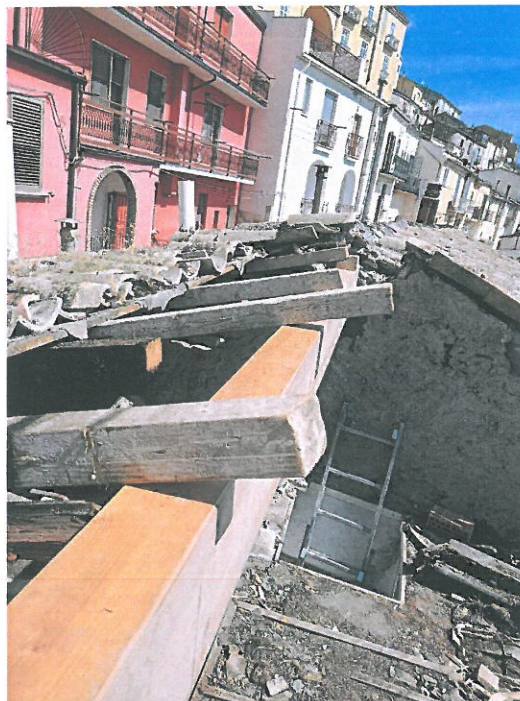
Trave di colmo ed altre travi sostituite
