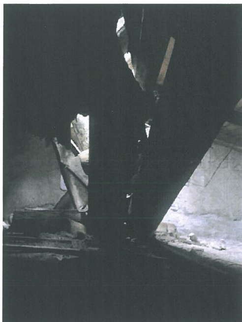
Trave di colmo spezzata
